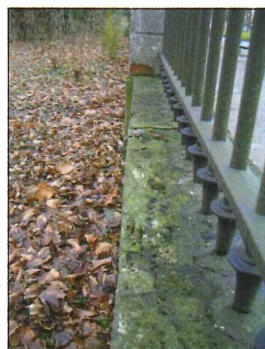
Abb. 46: Moosbewuchs auf der Sockelmauer. (Foto: Veronika König)
