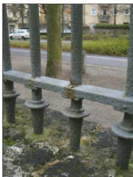
Abb. 45: Rost an einem Gitter. (Foto: Veronika König)
