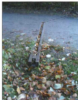
Abb. 55: Hölzerne Entwässerungsrinne nach historischem Vorbild. (Foto: Veronika König)
