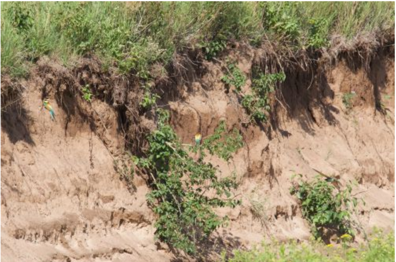
Abb. 9: Die in den 80er Jahren gut genutzte Brutwand der Uferschwalben bei Obereisenheim entfernte sich bei jedem Hochwasser durch regressive Erosion vom Wasser und wurde immer niedriger, so dass sie von Uferschwalben nicht mehr angenommen wird.
